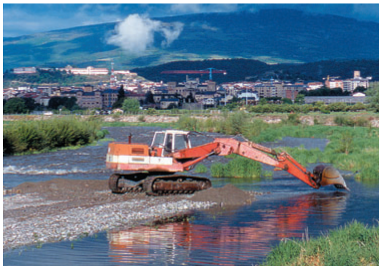
Màquina treient graves del llit del riu
